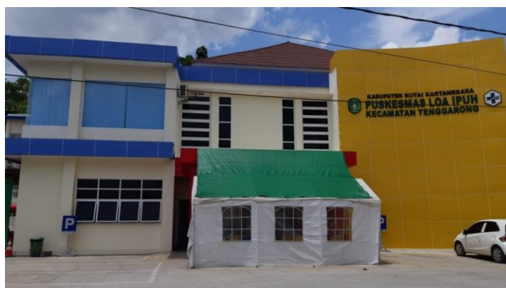
Gambar 4.2 Bangunan Puskesmas Loa Ipuh Tenggara
