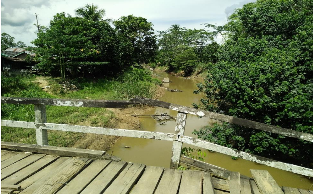
Gambar 5. Satu satunya jembatan penghubung di Desa Jonggon Desa
