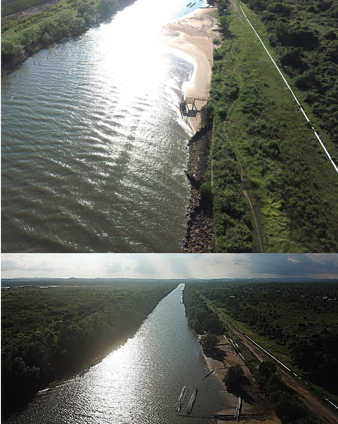
Gambar 4.05. Kondisi di Sekitar Kanal Terminal Santan
