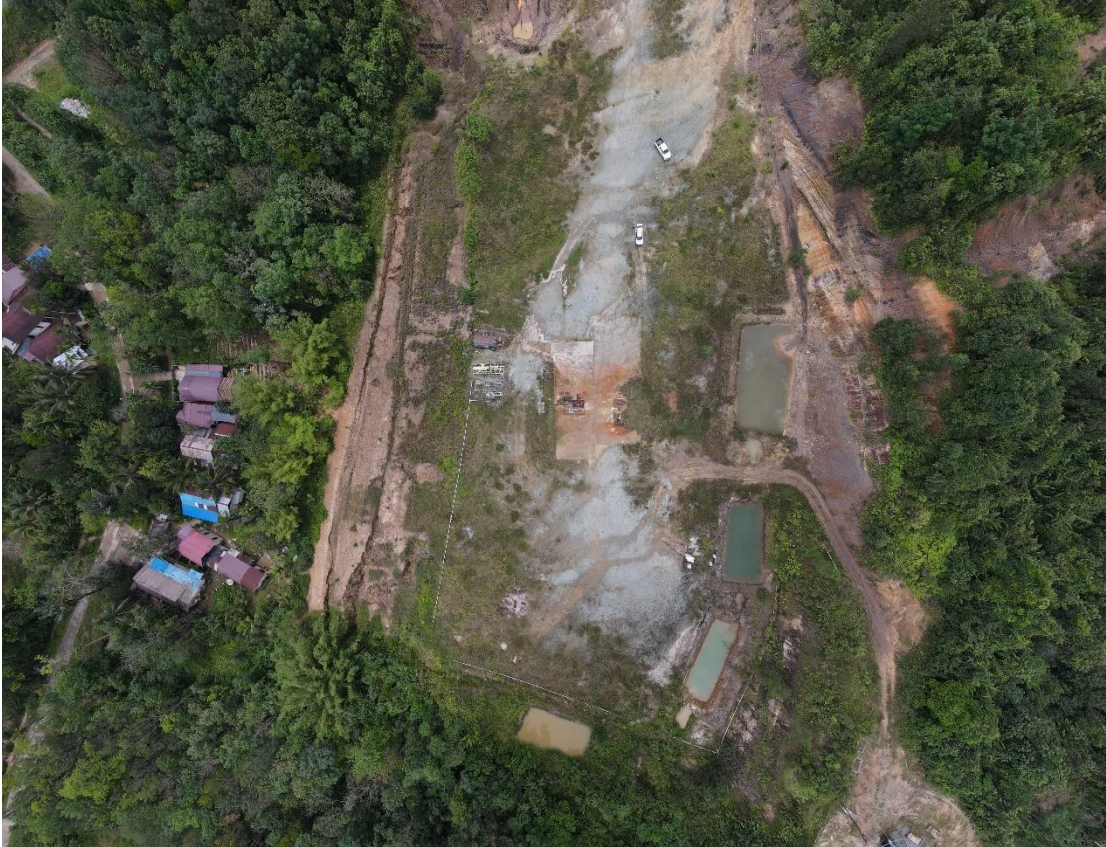
Gambar 2.05. Photo drone Area Sumur Produksi 1119 yang menjadi Target Monitoring di Pertamina EP Sanga Sanga
