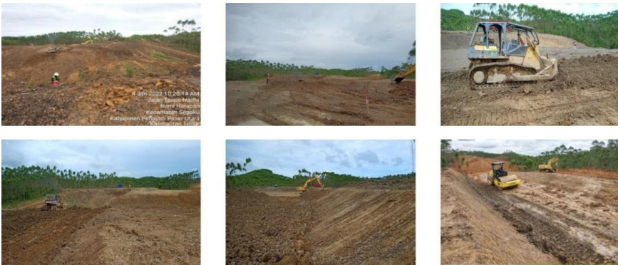
Gambar 6. Land clearing yang terus dikerjakan di kawasan IKN.
