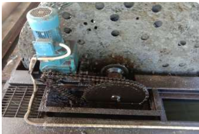
Gambar 4.20 Gear Penggerak RBC
