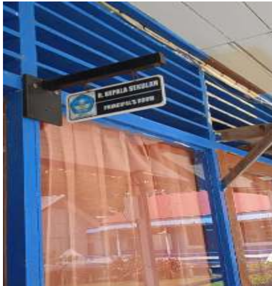
Gambar 5.22 Ruang Pimpinan SMPN 001 Long Bagun
