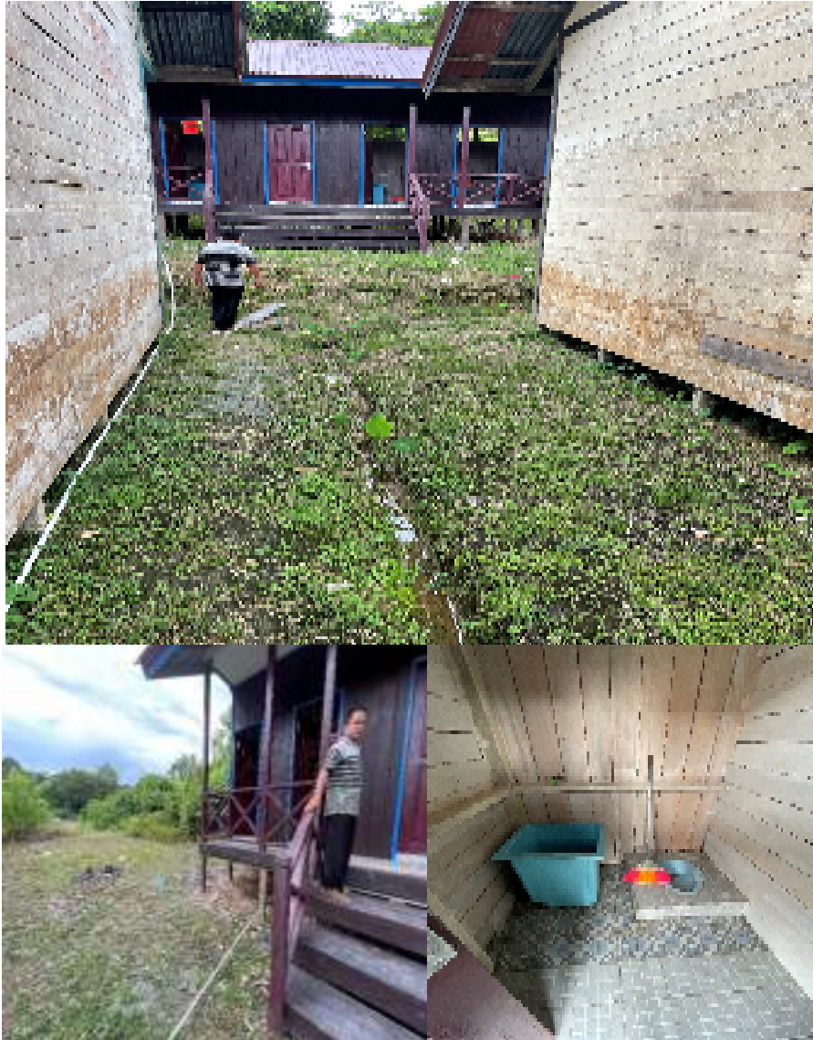
Gambar 4.236. Jamban di SDN 001 Long Hubung
