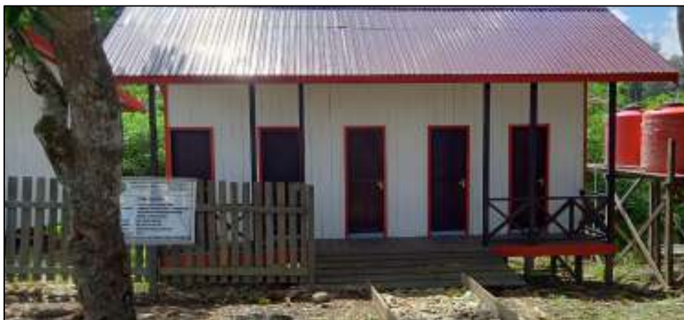
Gambar 4.41. Water Closet di SDN 001 Long Pahangai
