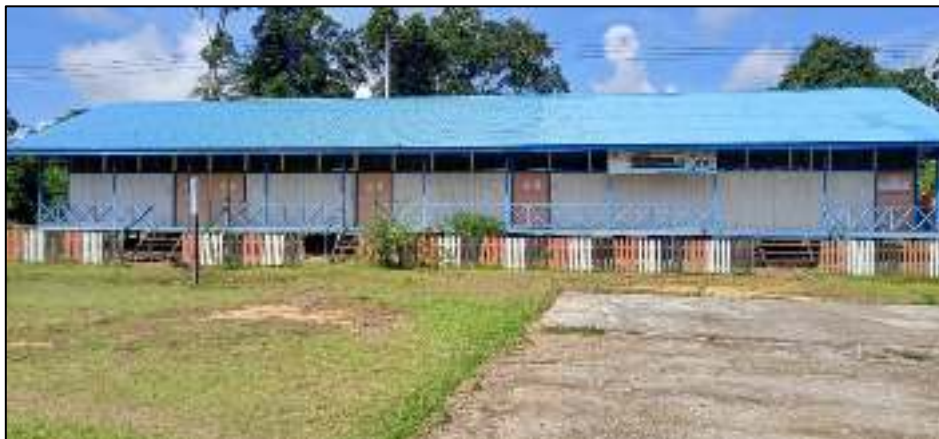
Gambar 4.42. Lapangan Olahraga/Bermain di SDN 001 Long Pahangai
