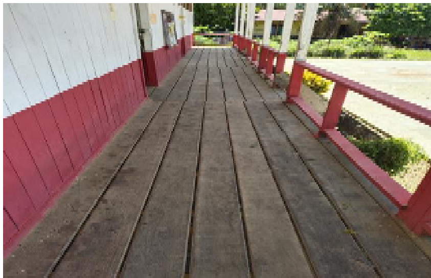
Gambar 4.119. Ruang Sirkulasi di SDN 003 Long Bagun Ilir
