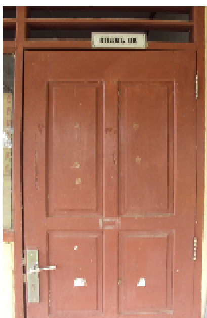
Gambar 5.104. Ruang Konseling di SMPN 4 Long Hubung
