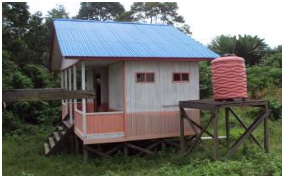
Gambar 4.283. Jamban di SDN 008 Mamahaq Teboq
