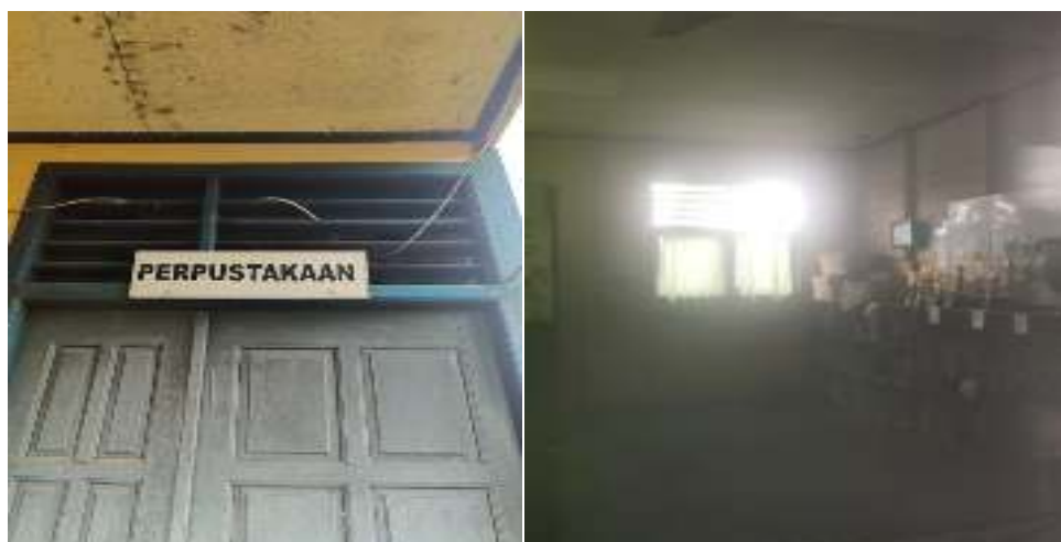
Gambar 4.245. Ruang Perpustakaan di SDN 003 Datah Bilang
