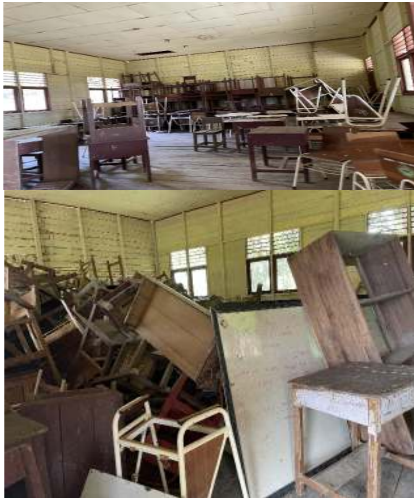
Gambar 5.82. Gudang di SMPN 1 Long Hubung
