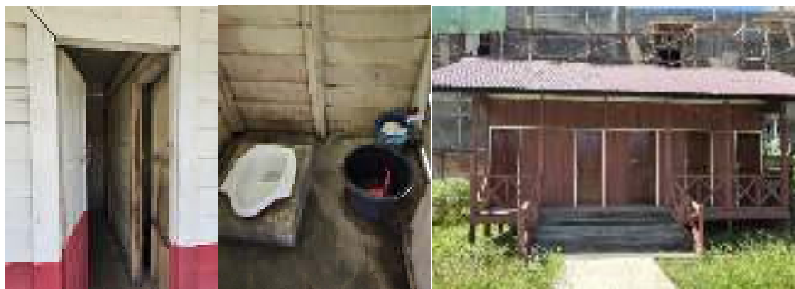
Gambar 4.118. Jamban di SDN 003 Long Bagun Ilir
