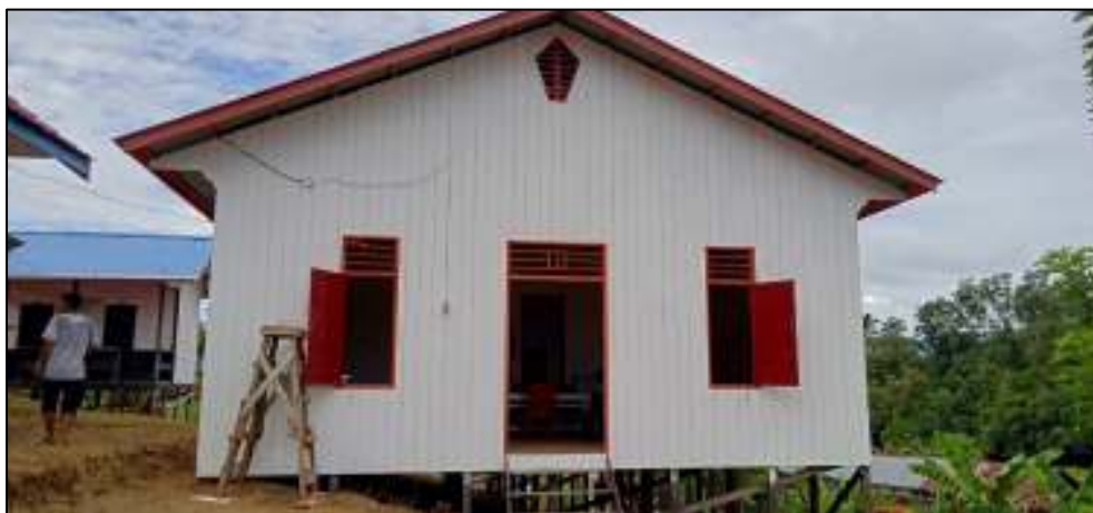
Gambar 4.74. Gedung Ruang Pimpinan SD Negeri 007 Long Pakaq Baru
