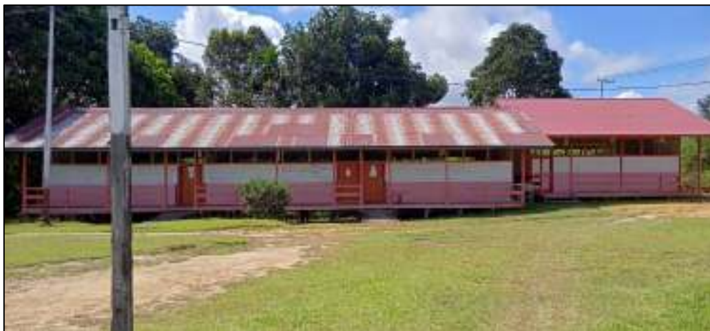
Gambar 4.49. Lapangan Olahraga/Bermain di SDN 002 Long Pahangai
