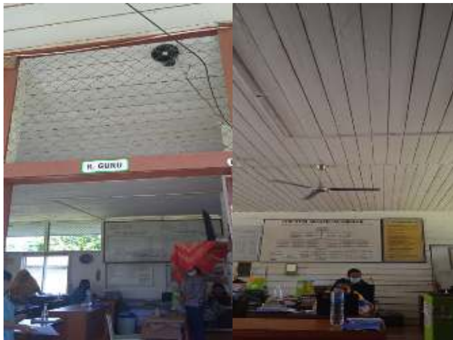
Gambar 4.98. Ruang Guru SDN 001 Ujoh Bilang
