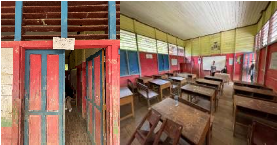
Gambar 4.230. Ruang Kelas 4 SDN 001 Long Hubung
