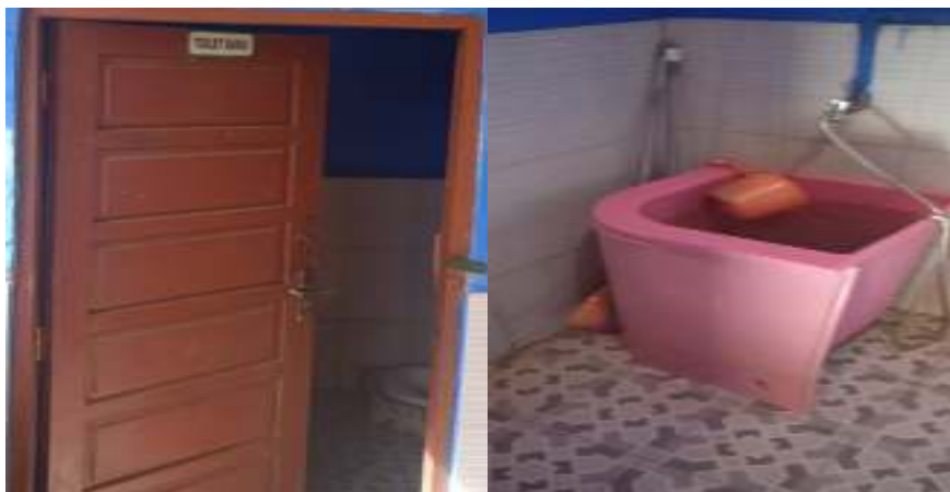
Gambar 4. 101. Jamban/Toilet SDN 001 Ujoh Bilang
