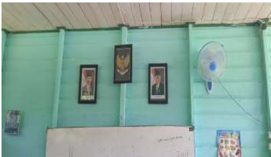
Gambar 4.88. Ruang Kelas 2A SD Negeri 001 Ujoh Bilang
