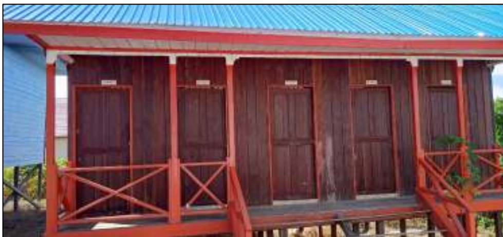
Gambar 4.76. Water Closet SD Negeri 007 Long Pakaq Baru
