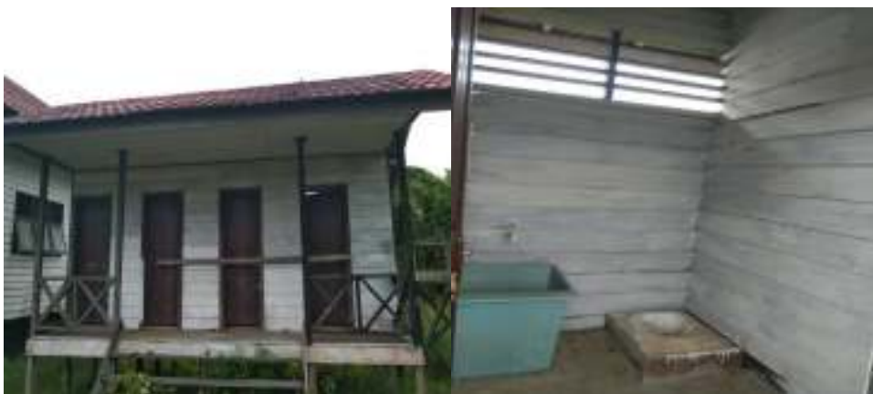
Gambar 4.214. Jamban di SDN 004 Nyaribungan
