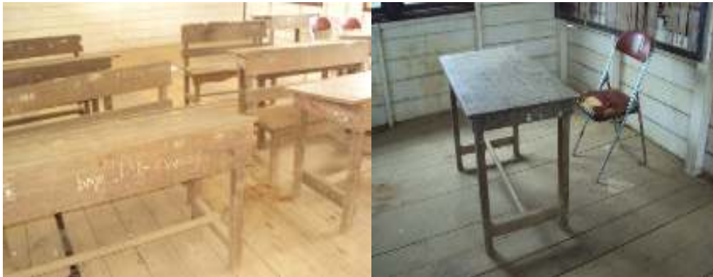
Gambar 4.276. Ruang Kelas 3 di SDN 008 Mamahak Teboq
