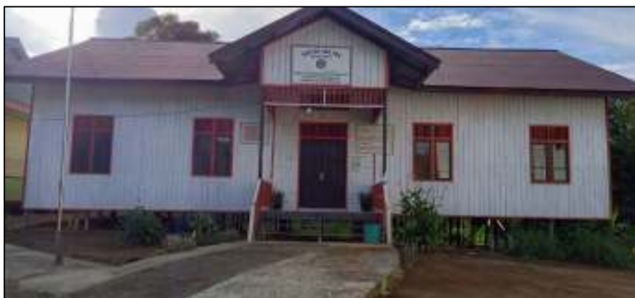
Gambar 4.81. Gedung Ruang Pimpinan SD Negeri 008 Datang Maring
