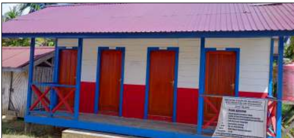
Gambar 4.48. Water Closet di SDN 002 Long Pahangai
