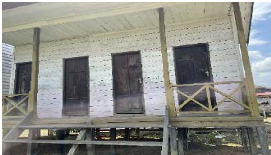
Gambar 4.163. Bangunan Jamban SDN 009 Long Merah
