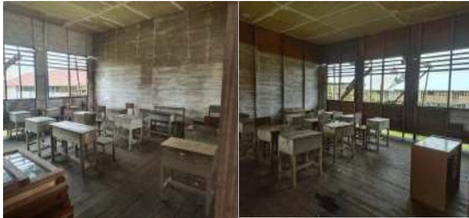
Gambar 4.238. Ruang Kelas di SDN 002 Datah Bilang yang Sedang Direnovasi
