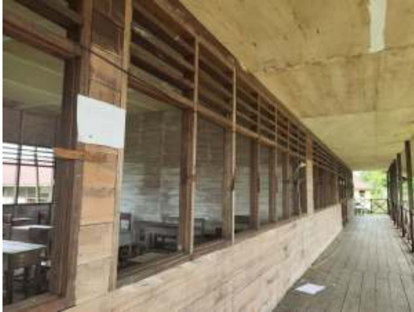
Gambar 4.240. Ruang sirkulasi pada bangunan lama SDN 002 Datah Bilang
