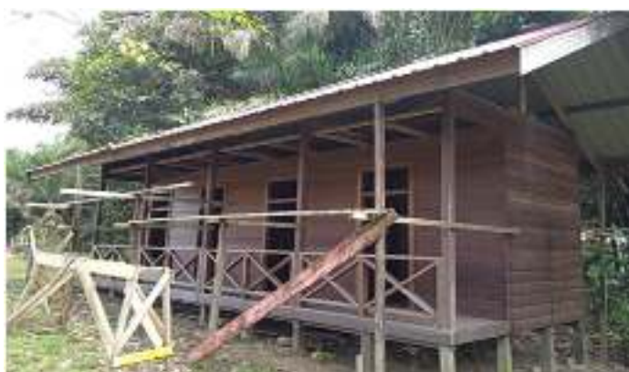
Gambar 4.202. Jamban di SD Negeri 002 Ratah
