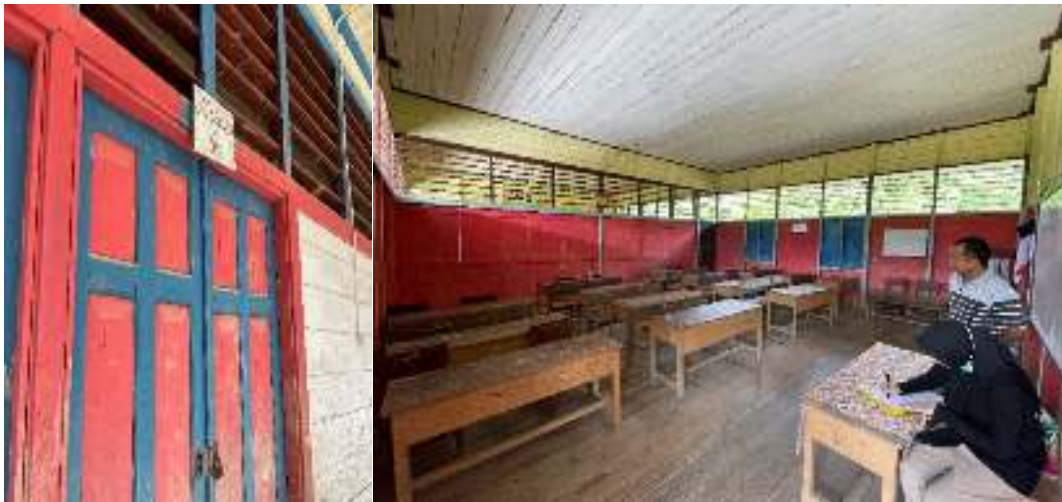
Gambar 4.231. Ruang Kelas 5 SDN 001 Long Hubung
