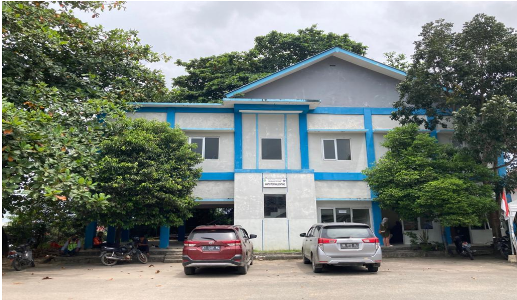
Kantor Dinas Perhubungan Sub Unit Terminas Bus Kota Bontang
