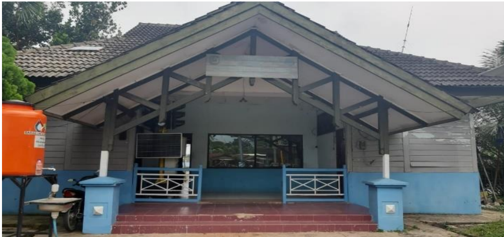
Gambar 5.25. Kantor Dinas Perhubungan Pada Terminal Bus Kota Bontang
