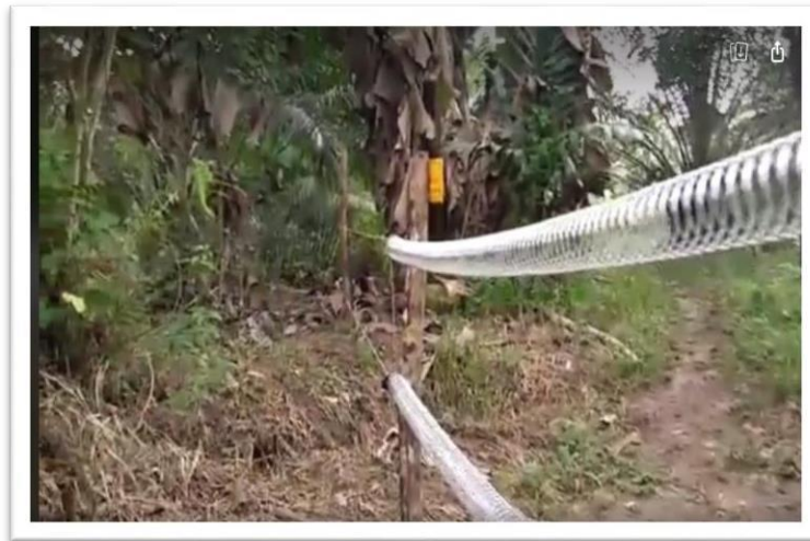
Gambar 2. Pemasangan Kabel Listrik
