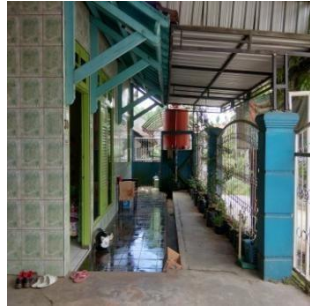
Gambar 1. Kondisi Awal Halaman Rumah
