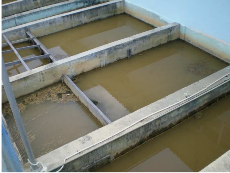
Lampiran 7.7 Bak Sedimentasi di IPA Cendana PDAM
