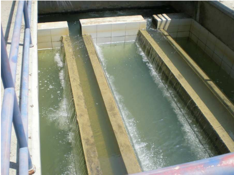
Lampiran 7.8 Bak Filter di IPA Gn. Lipan PDAM
