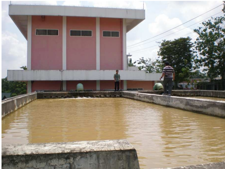
Lampiran 7.4 Bak Prasedimentasi di IPA Gn. Lipan
