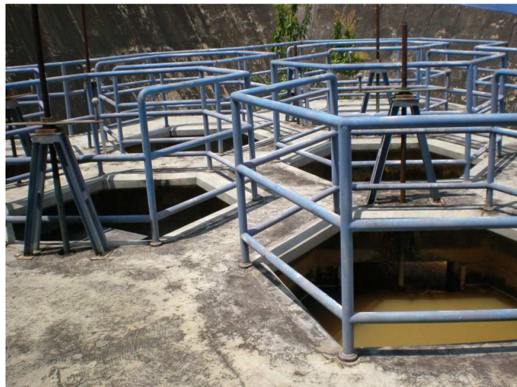
Lampiran 7.6 Bak Flokulasi di IPA Gn. Lipan PDAM
