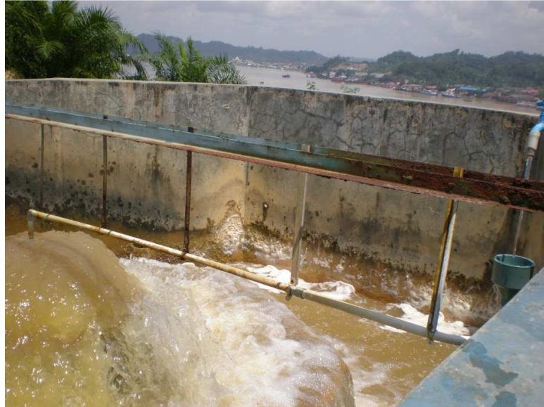
Lampiran 7.5 Bak Koagulasi di IPA Gn. Lipan PDAM
