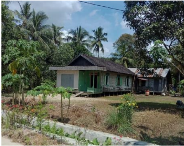
Gambar 8. 2 Kondisi Rumah di Lingkungan RT 20 (Sumber: Data Primer)
