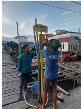
Gambar 1.2 Pemasangan Papan Penanda Batas RT di Desa Muara Telake
