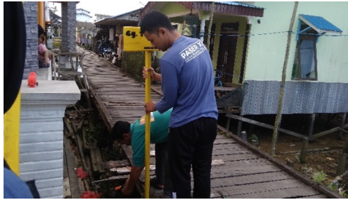
Gambar 1.1 Pemasangan Papan Penanda Gang di Desa Muara Telake
