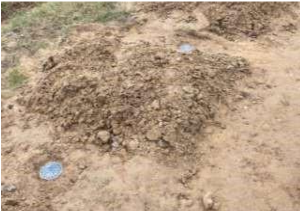
Gambar 5. Pemasangan Biopori
