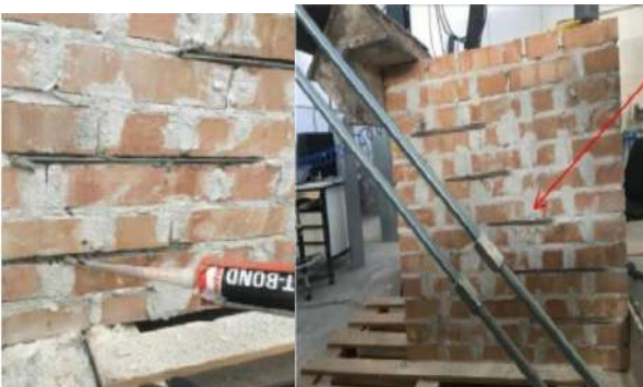
Gambar 7.9 Panel Dinding yang Dipasangi Batang Titanium
