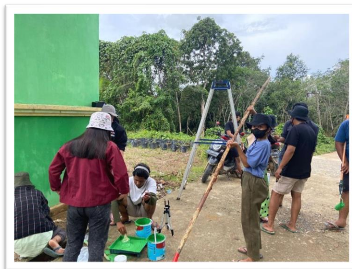
Gambar 5. Proses pengecatan gerbang
