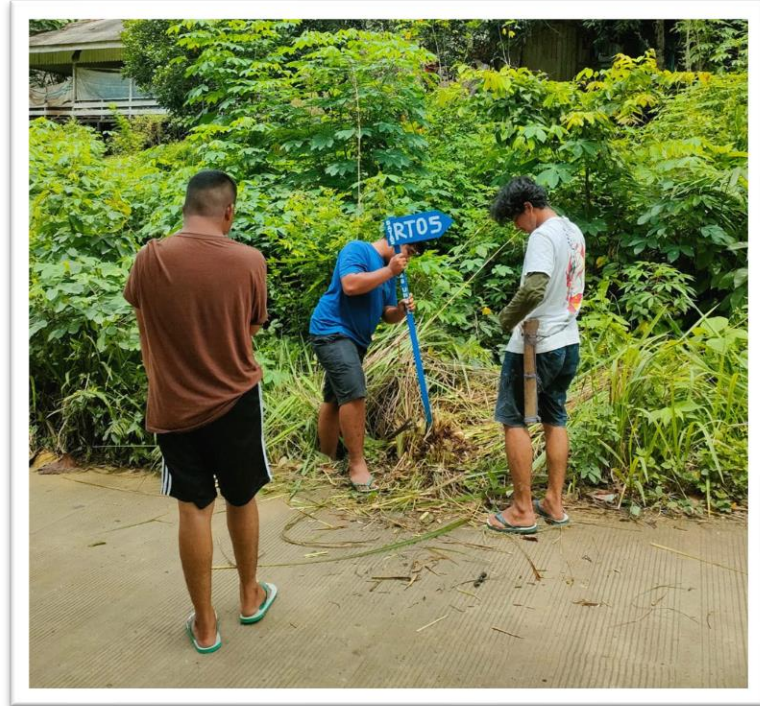
Gambar 9. Pemasangan patok batas RT
