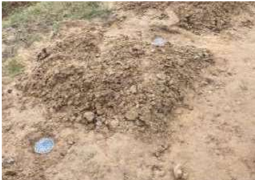
Gambar 5. Pemasangan Biopori
