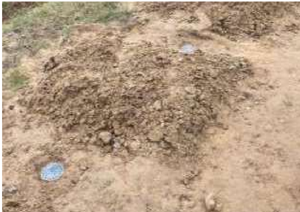
Gambar 5. Pemasangan Biopori
