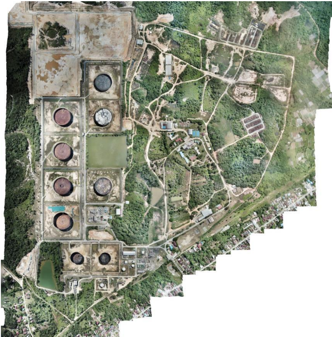
Gambar 4.01. Kondisi mutakhir penutupan lahan dan pemanfaatan ruang di Terminal Lawe-Lawe
