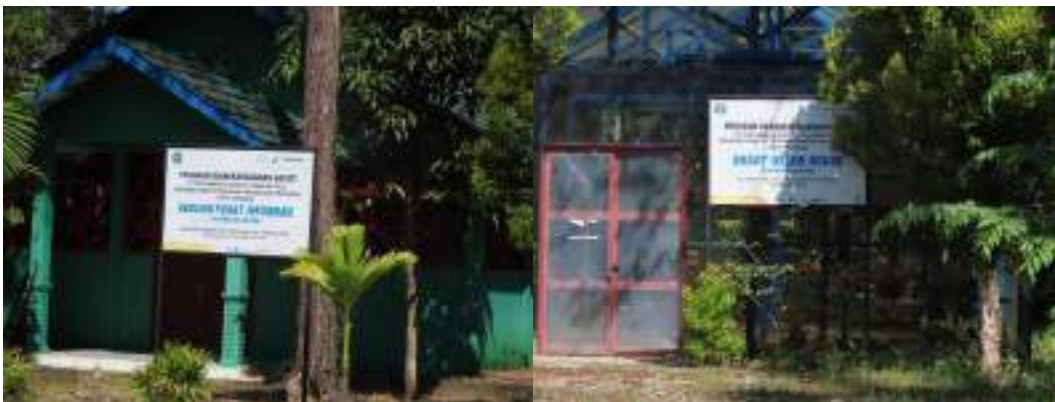
Gambar 4.08. Ruang Informasi dan Smart Green House yang Telah Dibangun Melalui program CSR PT Pertamina EP Tarakan Field
