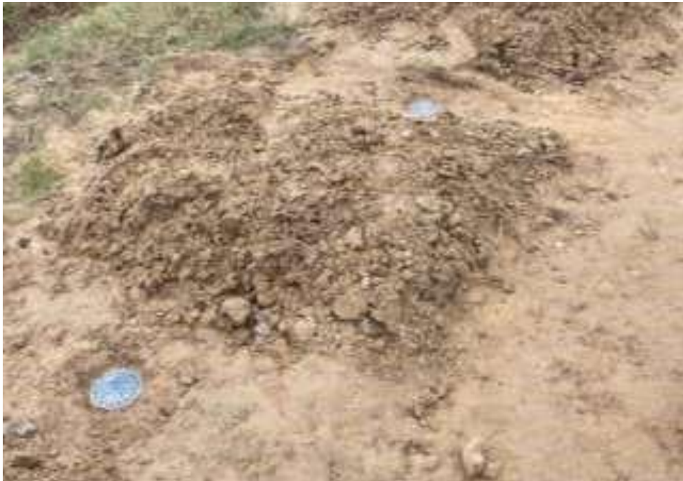
Gambar 5. Pemasangan Biopori
