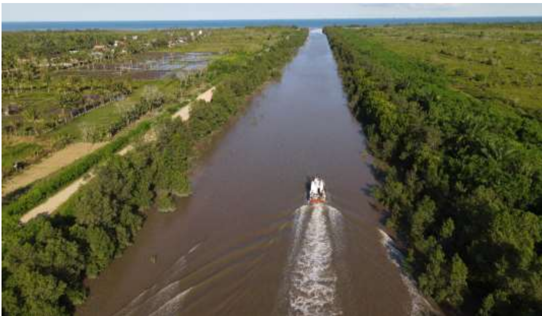
Gambar 4.03. Kondisi Kanal Selatan dan Utara di Terminal Santan
