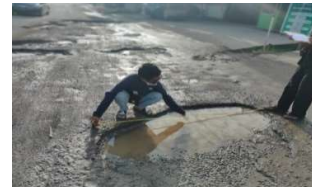
Gambar 15 Kerusakan Lubang
