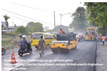
Gambar 2.6. Pelaksanaan Pekerjaan Jalan Menggunakan Limbah Plastik (Putri, 2018)
