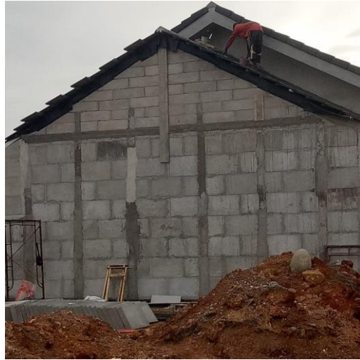
Gambar 8.3. Aplikasi Panel Pracetak Beton Ringan sebagai Dinding
