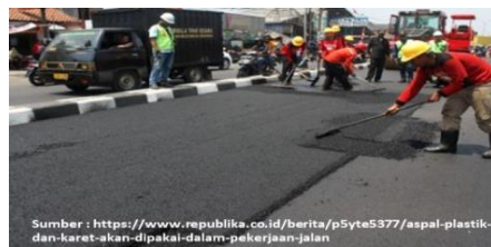
Gambar 2.6. Pelaksanaan Pekerjaan Jalan Menggunakan Limbah Plastik (Putri, 2018)
