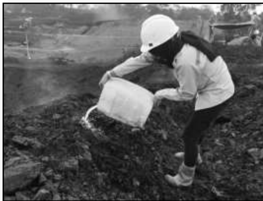
Gambar 2. Penyiraman Menggunakan Larutan Deterjen pada Titik yang Mengalami Self Heating
