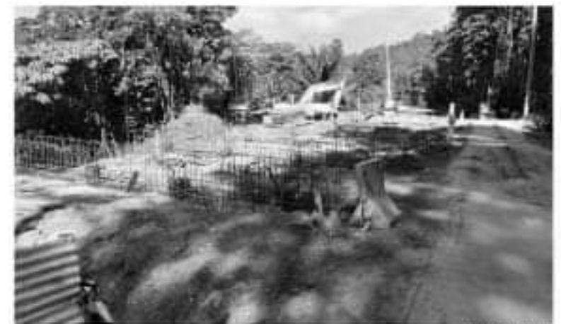
TERUS DIKERAJAKAN: proyek perbaikan akses jalan longsor yang kini terus berlanjut dan ditarget bisa beres akhir November mendatang.
