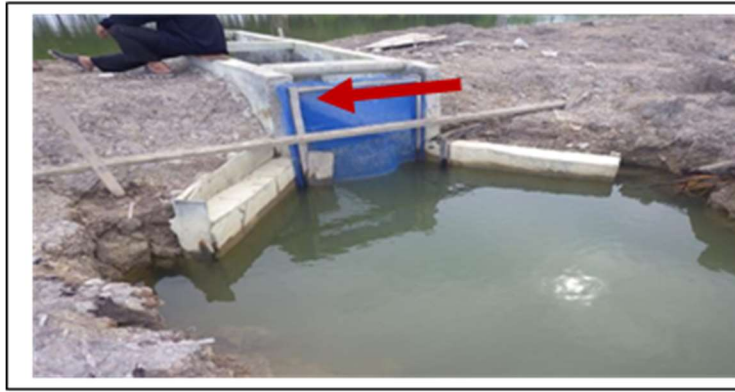
Gambar 36. Saringan harus dipasangkan dahulu sebelum mengisi tambak
