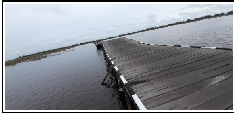
Gambar 5.45. Jembatan Ulin Penghubung Desa Melintang
