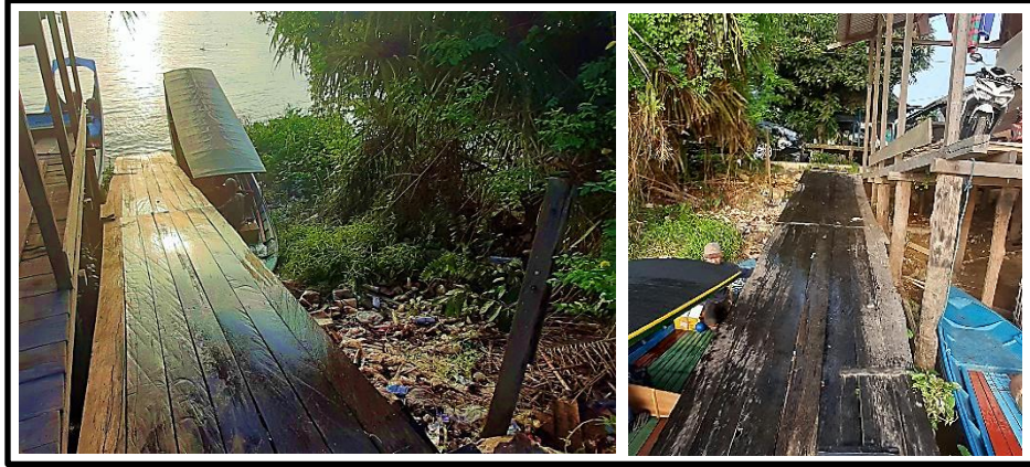
Gambar 5.57. Dermaga eksisting yang digunakan wisatawan dalam menyebrang menuju Desa Pela pada Kecamatan Kota Bangun
