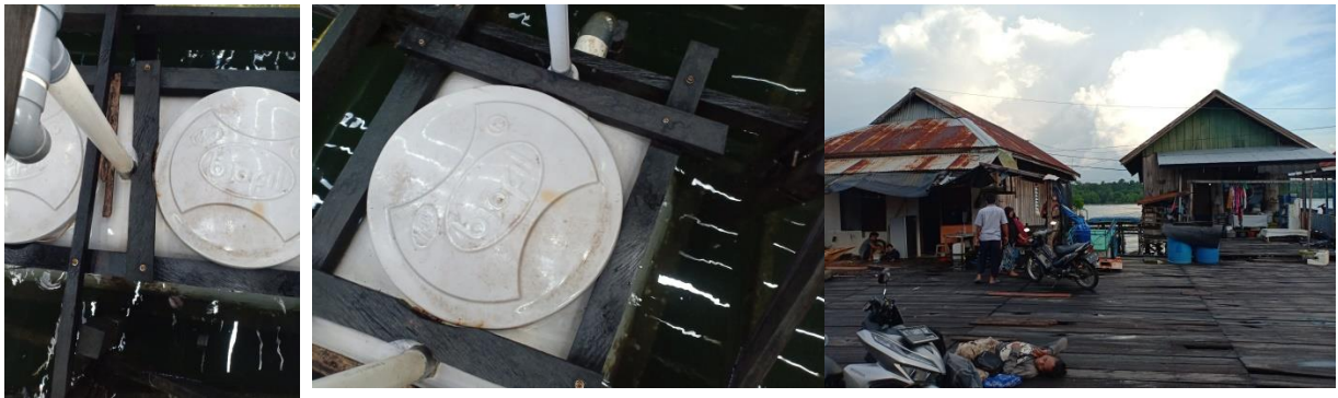
Gambar 8.12 Septic Tank Komunal dan Rumah Warga Lokal sebagai Pengguna di RT.01 Kampung Selambai di Kelurahan Loktuan Kecamatan Bontang Utara
