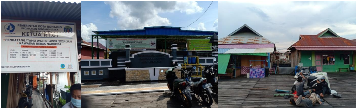
Gambar 8.7 Septic Tank Komunal di RT.01 Kampung Selambai di Kelurahan Loktuan Kecamatan Bontang Utara
