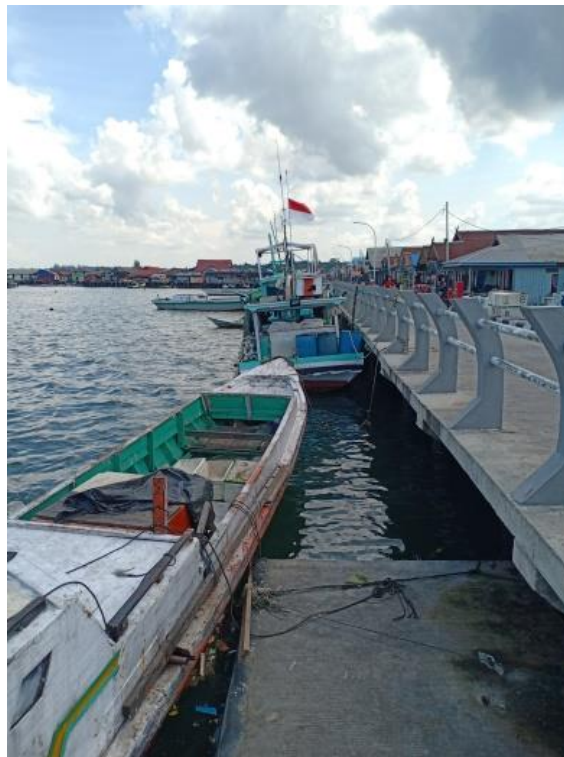
Gambar 4.12 Tambatan Kapal Nelayan dan Jembatan Beton di Kelurahan Loktuan
