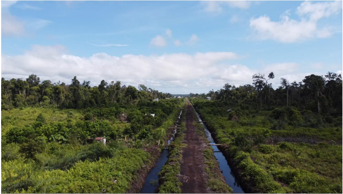
Gambar 31: Jalan poros dengan parit-parit yang juga berfungsi untuk mengeringkan lahan basah gambut. (Sumber: Japsika)
