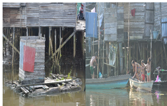
Gambar 3. Kondisi Sarana Pembuangan Kotoran(Jamban) Rumah Tangga Pemukim
