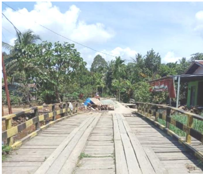
Gambar 8. 1 Kondisi Jembatan di Lingkungan RT 20 (Sumber: Data Primer)
