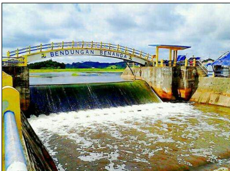
Gambar 12. Bangunan bendungan pengendali Benanga di Kalimantan Timur (Foto: M. Agus Adhi).
