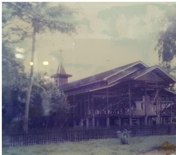
Foto 20. Renovasi Gereja Katolik Paroki Hati Kudus Yesus Laham Tahun 1998 (Tampak Bagian Belakang). (Dok. Koleksi Gereja)
