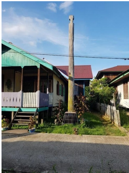
Foto 46. Bekas Tiang Rumah
