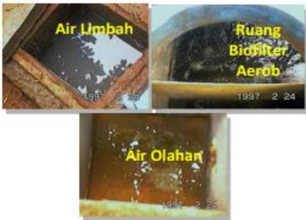
Gambar 3.11. Contoh IPAL Semi Komunal dengan proses Biofilter Anaerob-Aerob kapasitas 6 M 3 per hari
