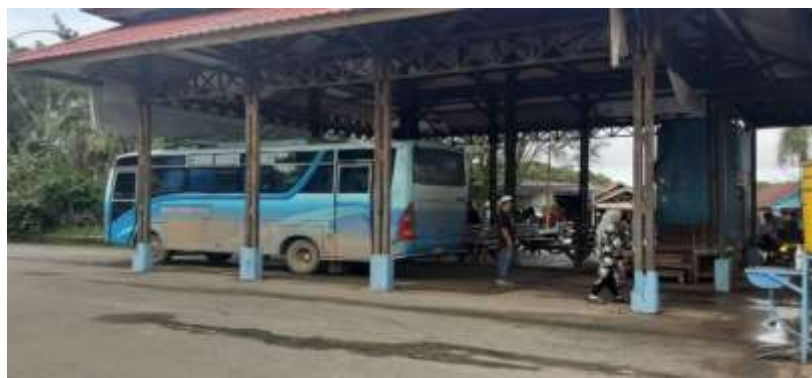
Gambar 5.27. Kondisi Terminal Angkutan Bus Kota Bontang (saat observasi)
