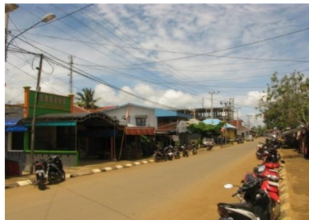
Kondisi Jalan Kabupaten Di Sesayap
