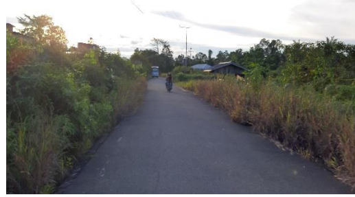
Kondisi Jalan Lokal (Lingkungan Permukiman) Di Kecamatan Tana Lia
