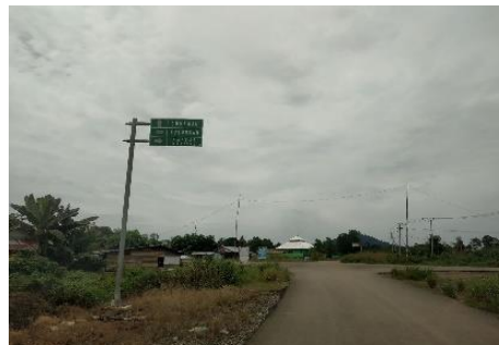
Kondisi Jalan Di Sesayap
