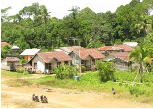
Jaringan Listrik Yang Sudah Mengakses Ke Permukiman Penduduk
