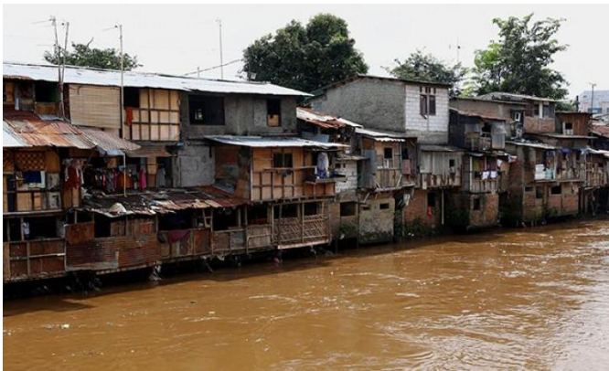
Gambar 9.2 Rumah Tidak Layak Huni di Bantaran Kali (Istimewa, 2017)
