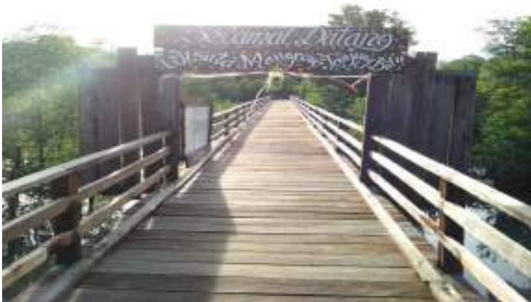
Gambar 1. Pintu masuk Track Ekowisata Mangrove
