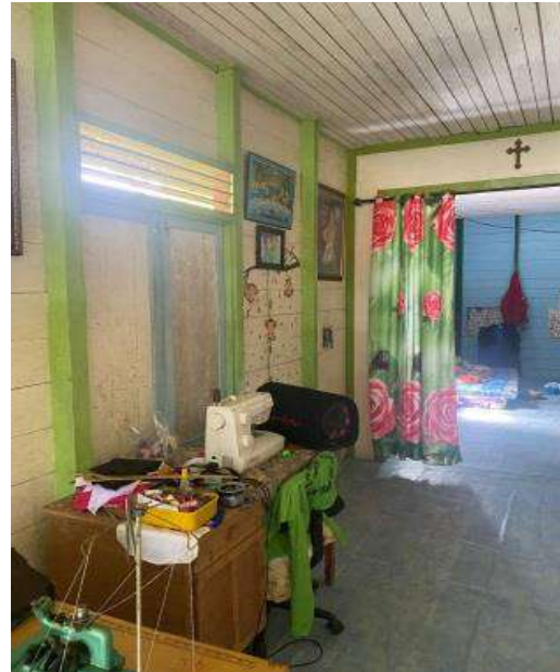
Pintu atau Jendela Yang Tidak Dibuka
