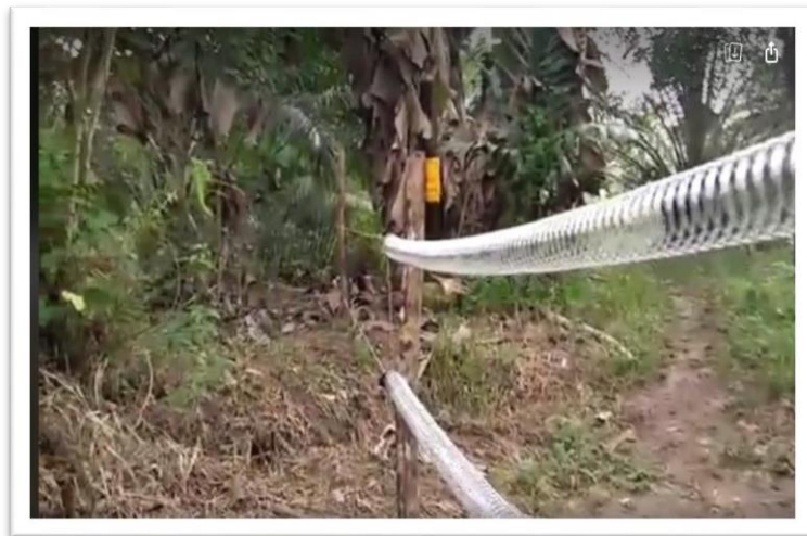
Gambar 2. Pemasangan Kabel Listrik
