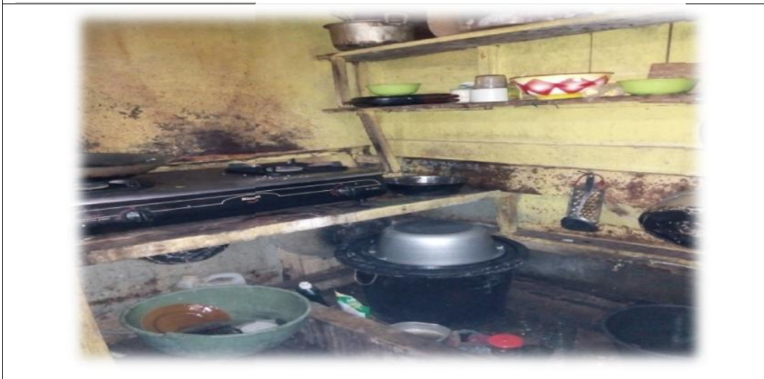
Kondisi Lantai dan Dapur
