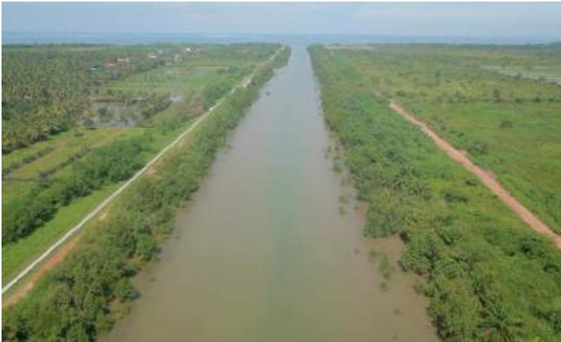
Gambar 4.04. Kondisi Kanal Selatan dan Utara di Terminal Santan
