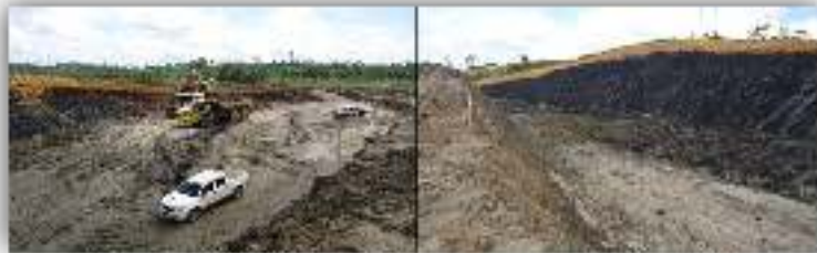
Gambar 2.3 Kegiatan Penambangan dan Backfilling di Pit B_74_2/3 (Tahun 2013)
