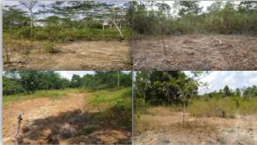
Gambar 2.49 Kejadian Erosi Tanah di Lahan Reklamasi (Tahun 2019)
