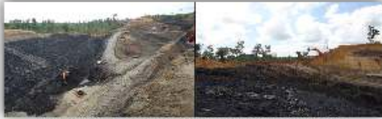
Gambar 2.4 Kegiatan Penambangan dan Backfilling di Pit C_65_2 (Tahun 2013)
