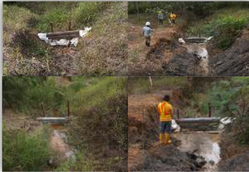
Gambar 2.46 Konstruksi Bangunan Konservasi Tanah dan Air (Kontan) (Tahun 2019)
