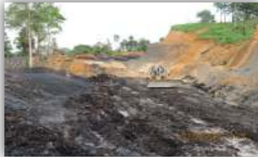
Gambar 2.30 Kegiatan Penambangan dan Backfilling di ID_C_65_6 (Tahun 2015)
