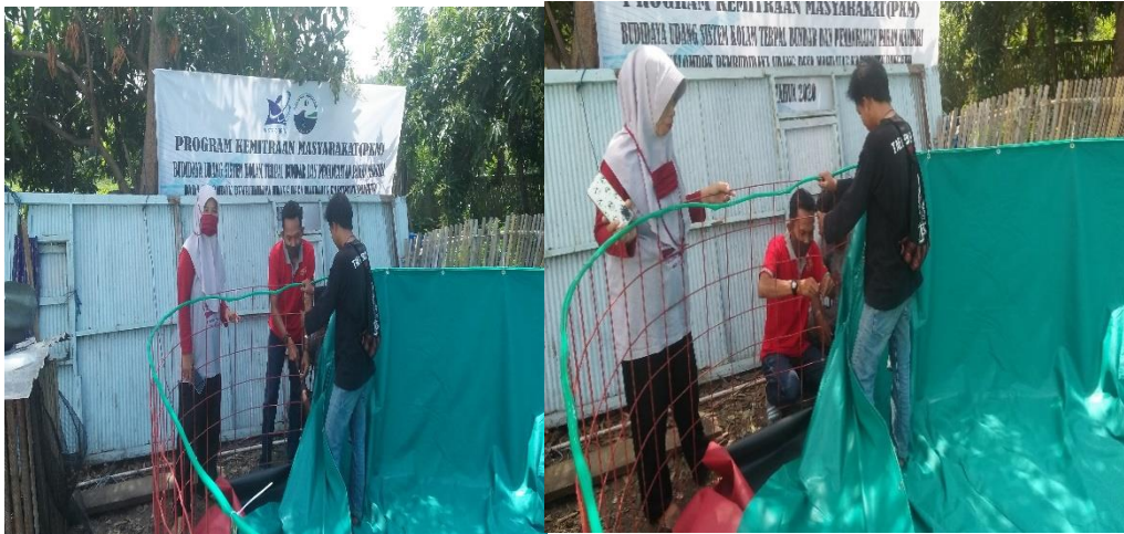
Gambar 5. Pemasangan kolam terpal bundar
