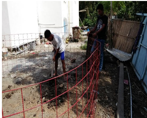
Gambar 1. Konstruksi besi kolam terpal bundar
