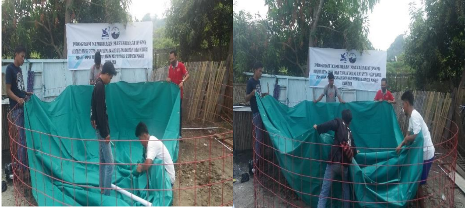
Gambar 2. Pembuatan saluran pembuangan dan pemasangan terpal
