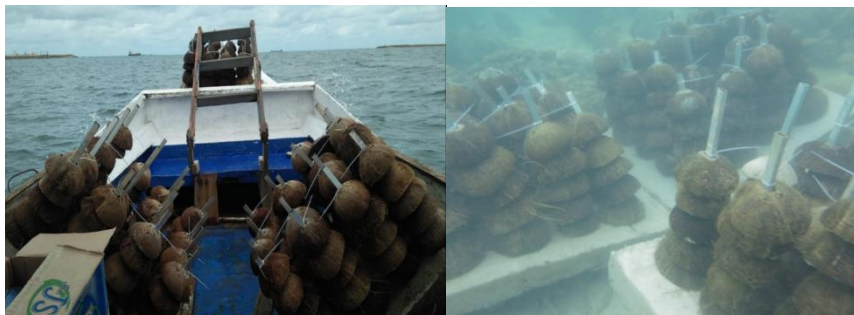
Gambar 1. Pengangkutan dan Pemasangan Bioreeftek
