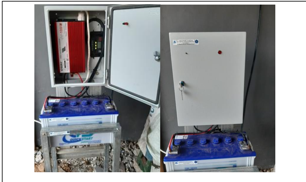
Gambar 3. Panel box dan sistem inverter PLTS
