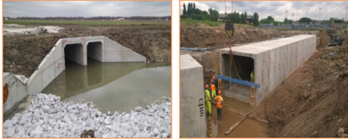
Gambar 9.4: Box Culvert Dengan Konstruksi Jalan di Atasnya
