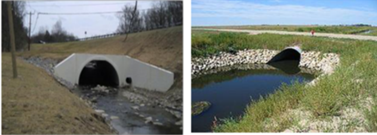
Gambar 9.3: Bangunan Pengontrolan Gorong-Gorong
