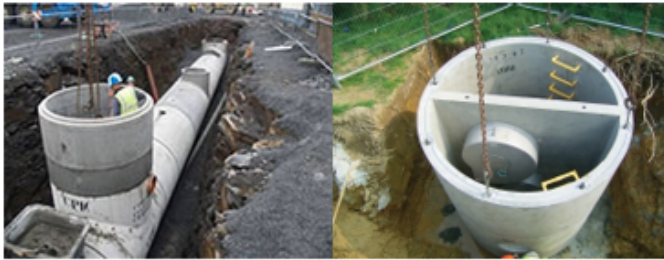
Gambar 5.1: Contoh Bak Kontrol (Manhole) Pada Saluran Tertutup
