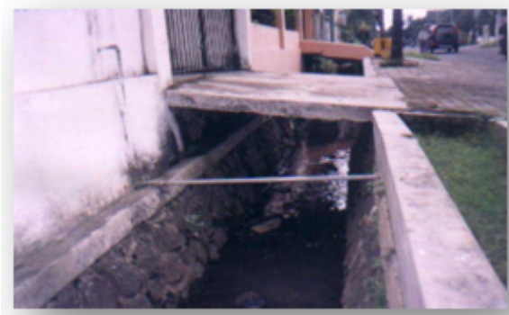
Gambar 10.2: Saluran Drainase Konvensional
