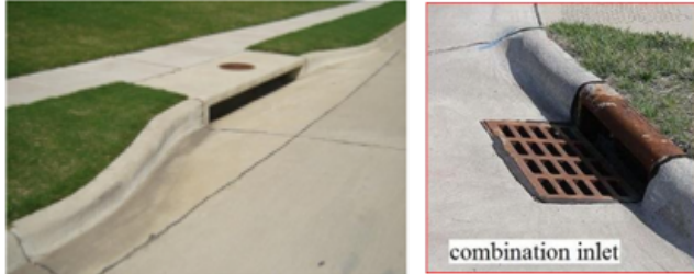
Gambar 2.12: Street Inlet ( Modul 2 Drainase perkotaan, 2017)
