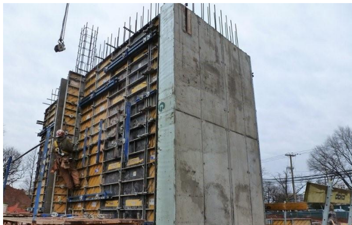
Gambar 26. Dinding geser ( shear wall )
