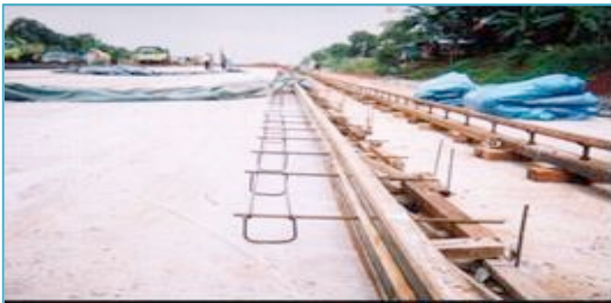
Gambar 2.7: Batang pengikat pada perkerasan kaku bersambung tanpa tulangan
