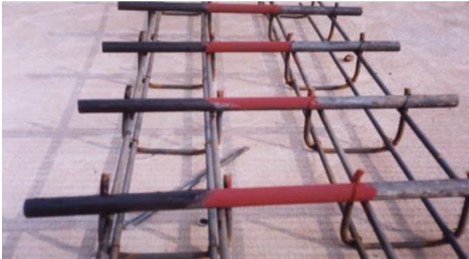
Gambar 2.6: Ruji pada perkerasan kaku bersambung tanpa tulangan
