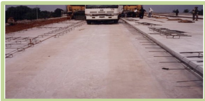
Gambar 2.8: Kedudukan batang pengikat pada sambungan memanjang
