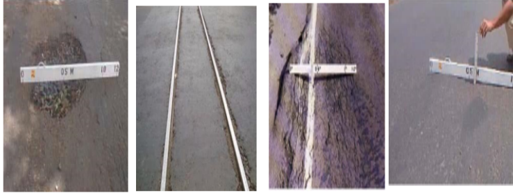
Gambar 9.6: Lubang, perpotongan rel, alur dan sungkur. Bina Marga no.03/MN/B/1983
