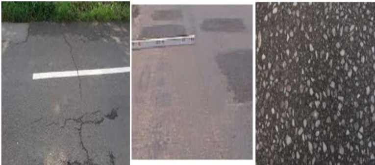
Gambar 9.5: Retak memanjang/melintang, tambalan, dan pengausan.
