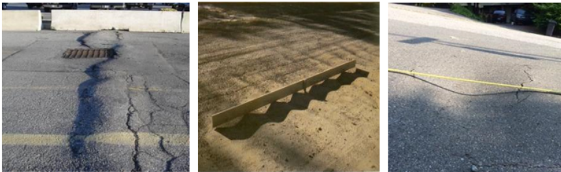
Gambar 9.3: Cekungan, bergelombang/keriting dan amblas Bina Marga no.03/MN/B/1983
